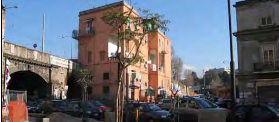
la demolizione di corso Novara
