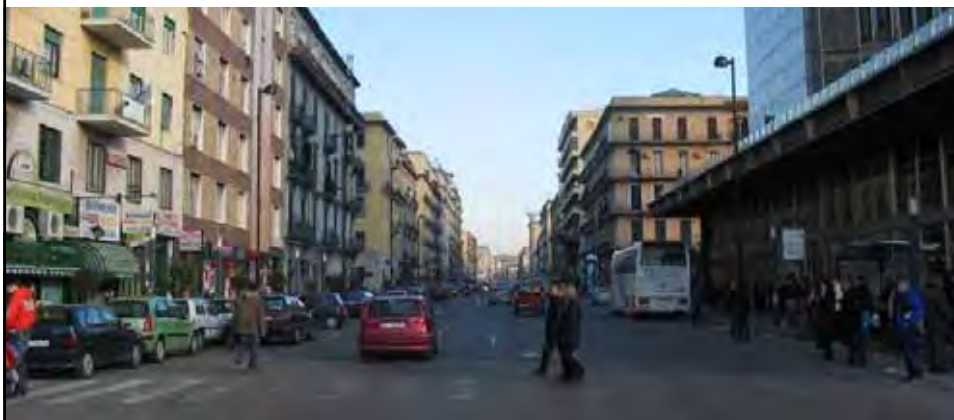
la demolizione di corso Novara
